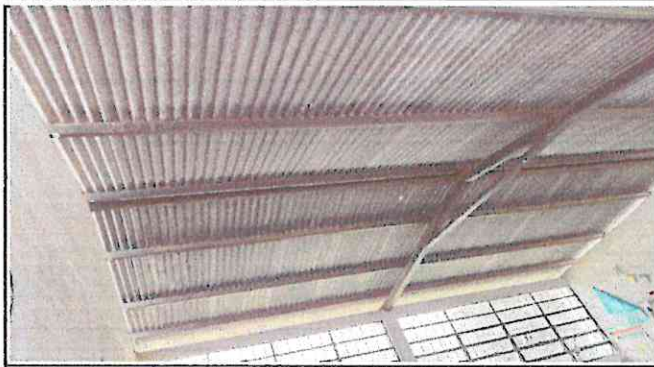
Foto 1: Sustrucción de lamina canalito por lamina troquelada Salon 3
