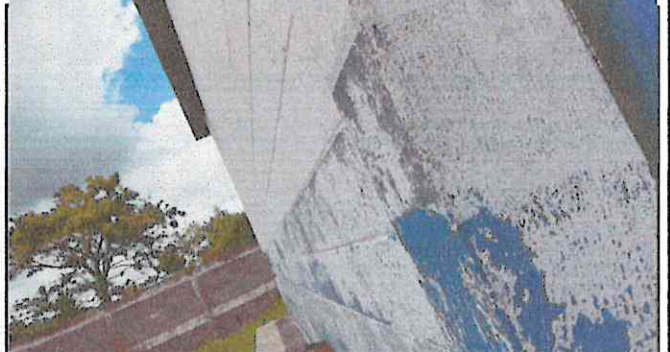
Foto 4: Pintura en exteriores de salones
