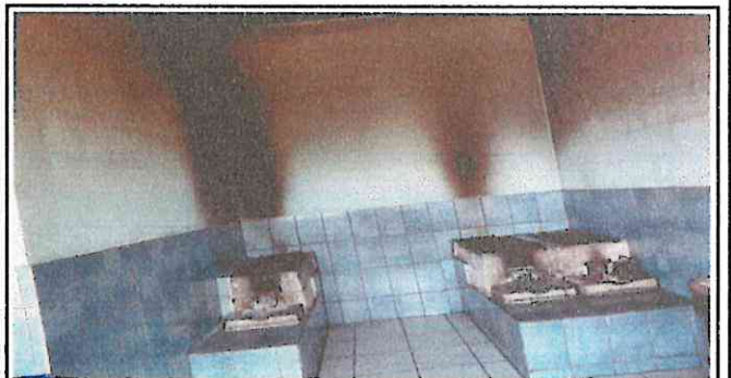
Foto 6: Implementacion de chimenea y sustrucción de plancha de 3 ornillas.
